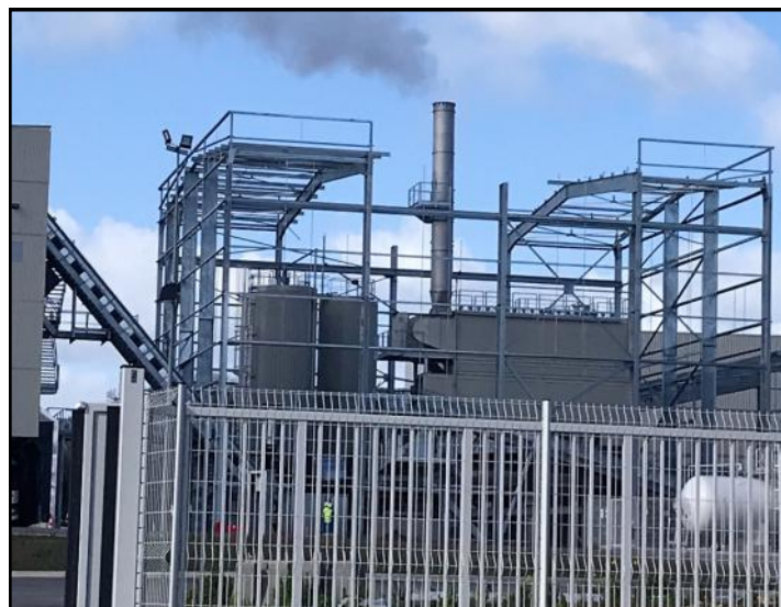
Travaux à l'usine Eurovia de Chammes
