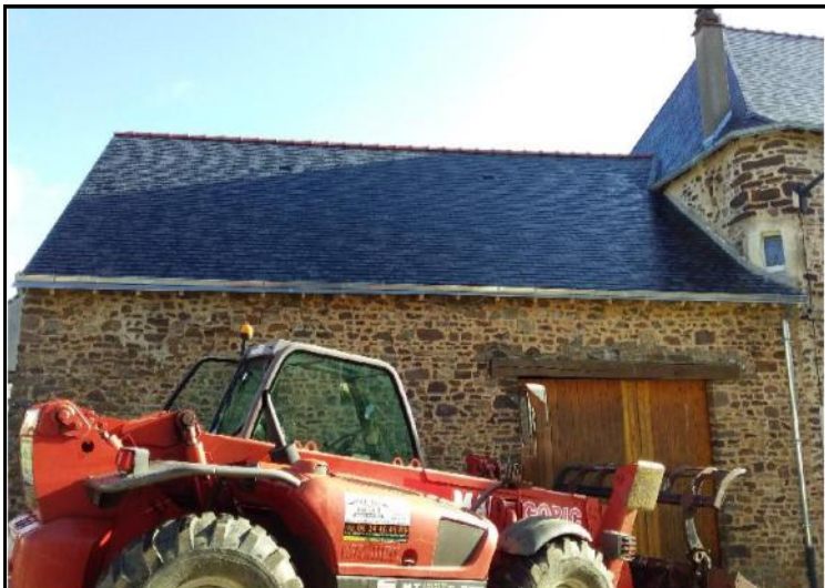
Travaux de réfection de la toiture de l'atelier communal à Chammes
