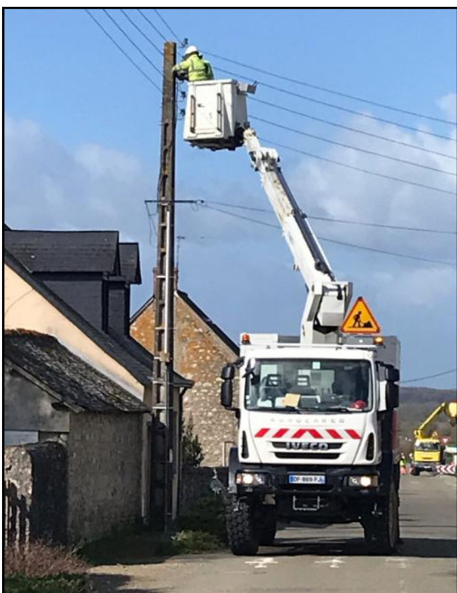
Fin des travaux d'enfouissement des réseaux électrique et téléphonique Rue de Montsûrs à Sainte-Suzanne
